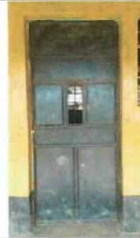
Foto 8: Reparación de puertas de aulas ya deterioradas.
