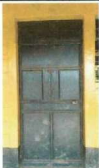
Foto 7: Reparación de puertas de aulas ya deterioradas.
