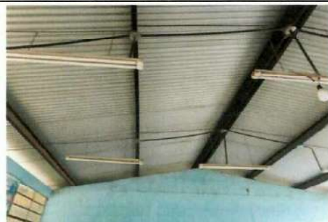
Foto 6: Substitución de cableado eléctrico y foco en tres aulas que ya no están funcionando.
