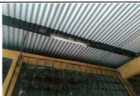
Foto 12: Reparación de espacio abierto de dirección con base de metal tipo balcon.
